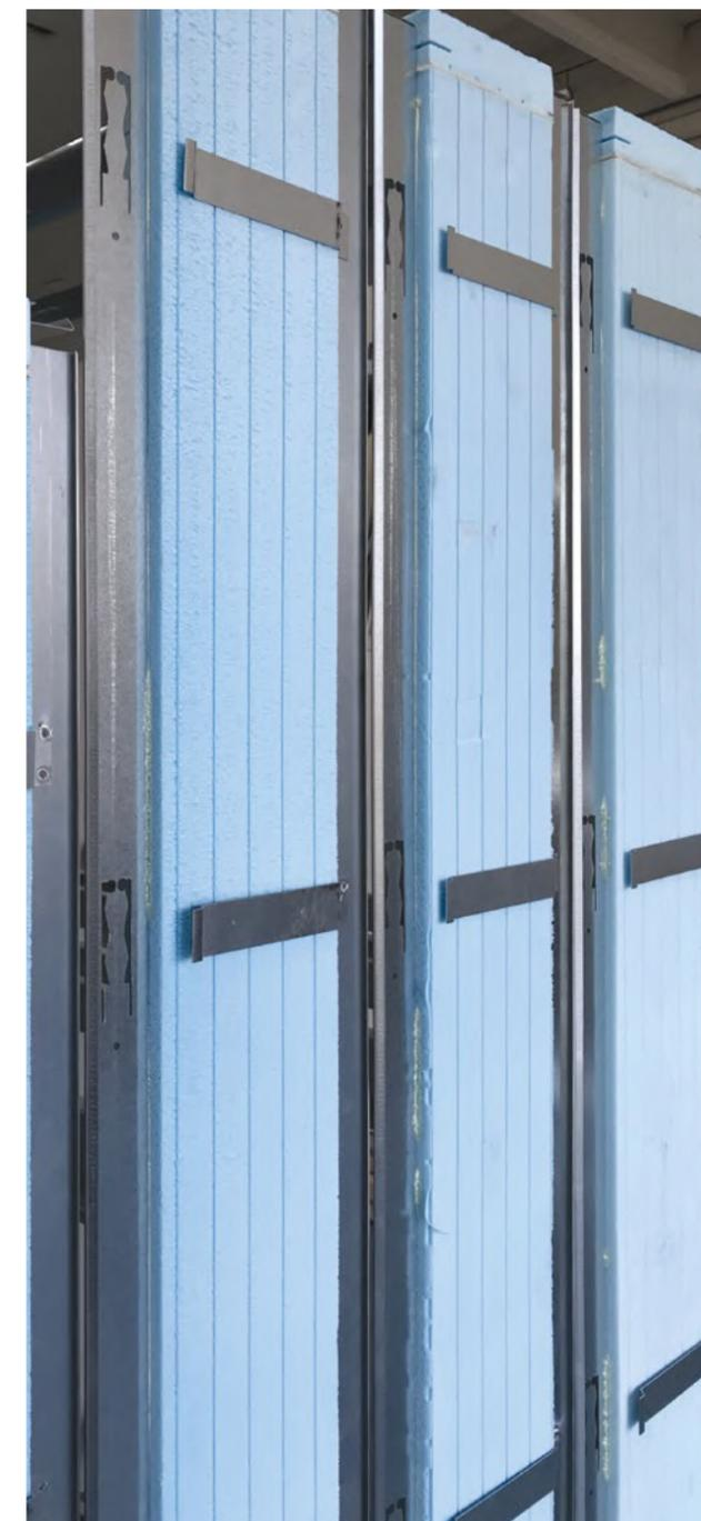
Il controtelaio è l'elemento che rifinisce il vano murario e funge da supporto per il fissaggio del serramento. È da considerarsi come l'elemento primario da cui poi sviluppare tutta la fornitura, abbinabili alle diverse tipologie di costruzione in uso oggi: strutture in legno o strutture murarie.
